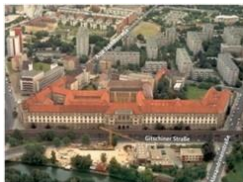
（德意志帝国专利局办公室新址航拍图）
